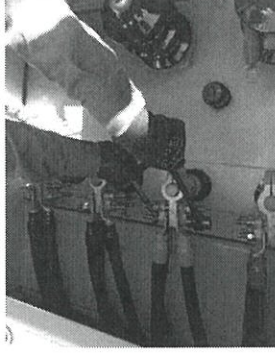
ขันตัวต่อสายไฟฟ้าด้านแรงต่ำ
