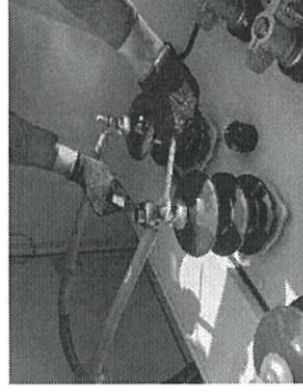
ขันตัวยึดสายไฟฟ้า ด้านแรงสูง
