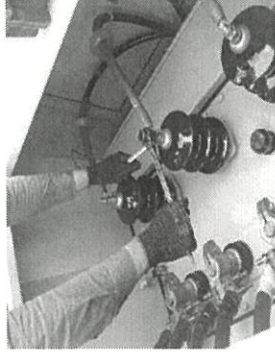
ขันยึดด้วยสายไฟฟ้าด้านบน
