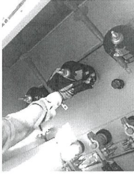
ทำความสะอาด Bushing ด้านแรงสูง
