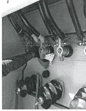
ทำความสะอาด Bushing ด้านแรงต่ำ
