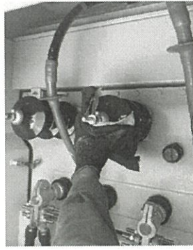
ทำการเชื่อมต่อ Bushing ด้านแรงสูง
